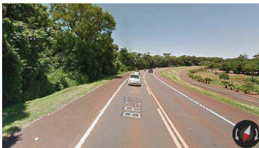
Figura 21 – Imagem de parte do trecho C.
