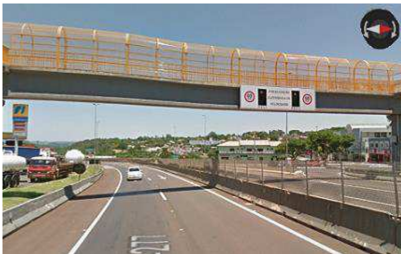
Figura 31 – Imagem de parte do trecho H, passarela de pedestres e fiscalização eletrônica.
