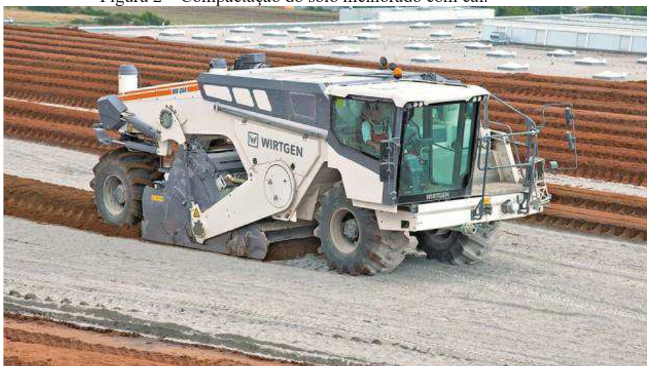
Figura 2 – Compactação do solo melhorado com cal.
