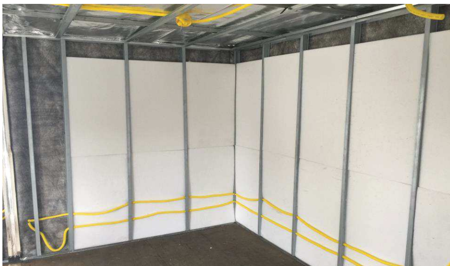
Figura 17 - Aplicação do isolamento acústico em contêineres
