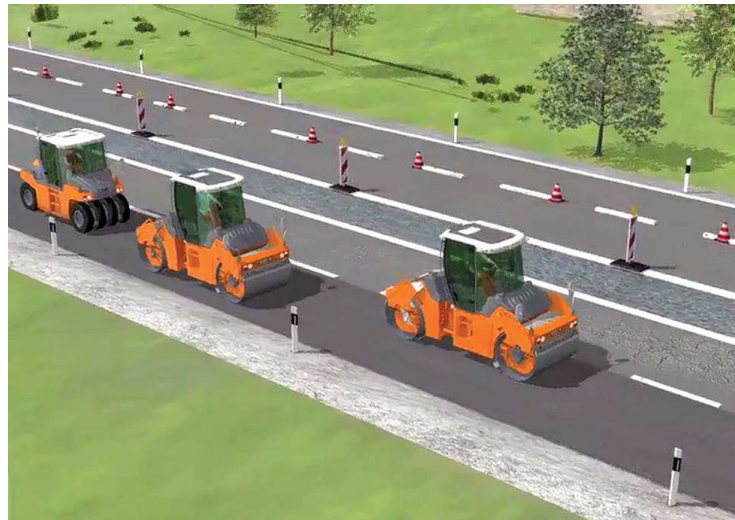
Figura 14 — Compactação convencional do pavimento.
