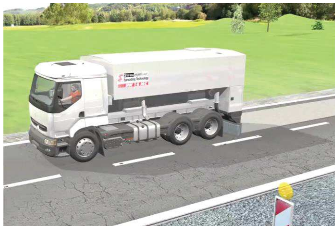
Figura 11 — Pulverização da calda de cimento por meio de bicos injetores.
