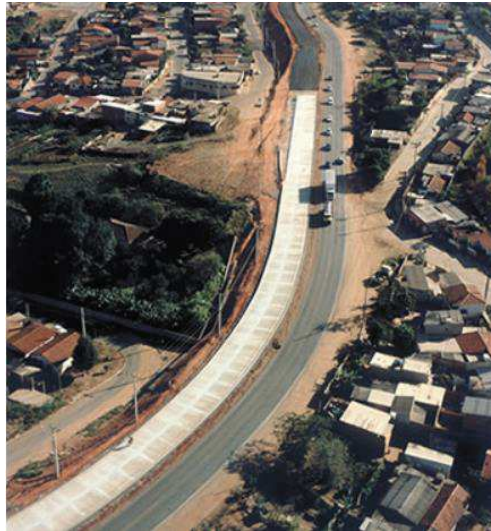
Figura 15 — Reabilitação do pavimento da rodovia SP-79 com whitetopping .
