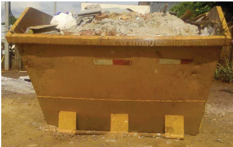
Figura 40 - Caçamba utilizada para disposição final dos resíduos.
