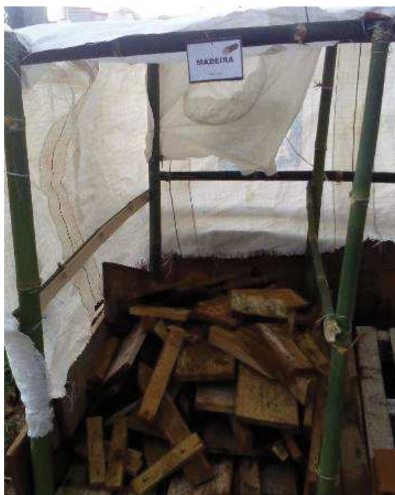
Figura 19 - Baia com placa de identificação.
