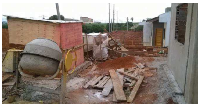
Figura 12 - Canteiro de obras com as baias ao fundo.
