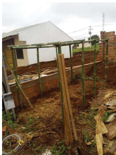
Figura 17 - Baias com toda estrutura de bambu colocada.
