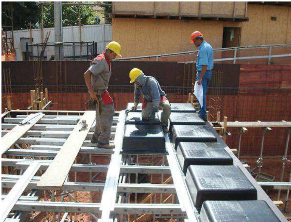
Figura 7 - Montagem de laje com fôrmas reutilizáveis
