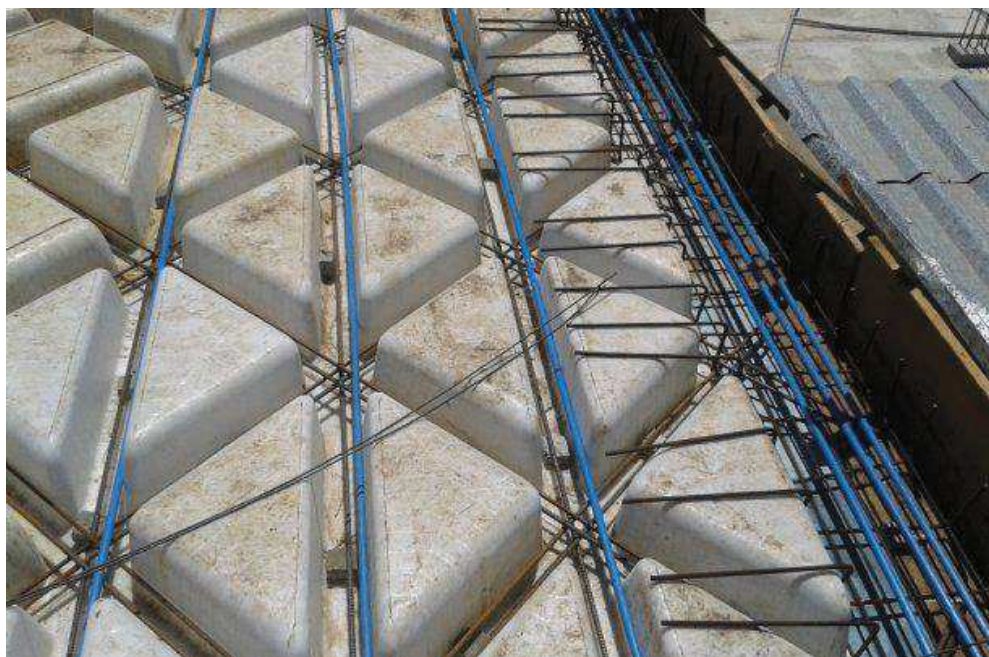
Figura 4 - Laje tridirecional
