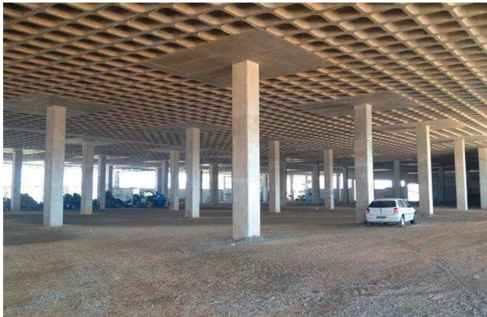
Figura 3 - Laje lisa nervurada feita com fôrmas reutilizáveis
