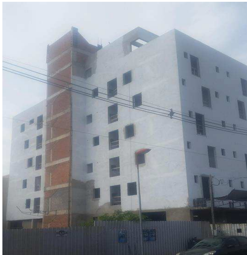
Figura 14 - Edifício Utilizado como Modelo
