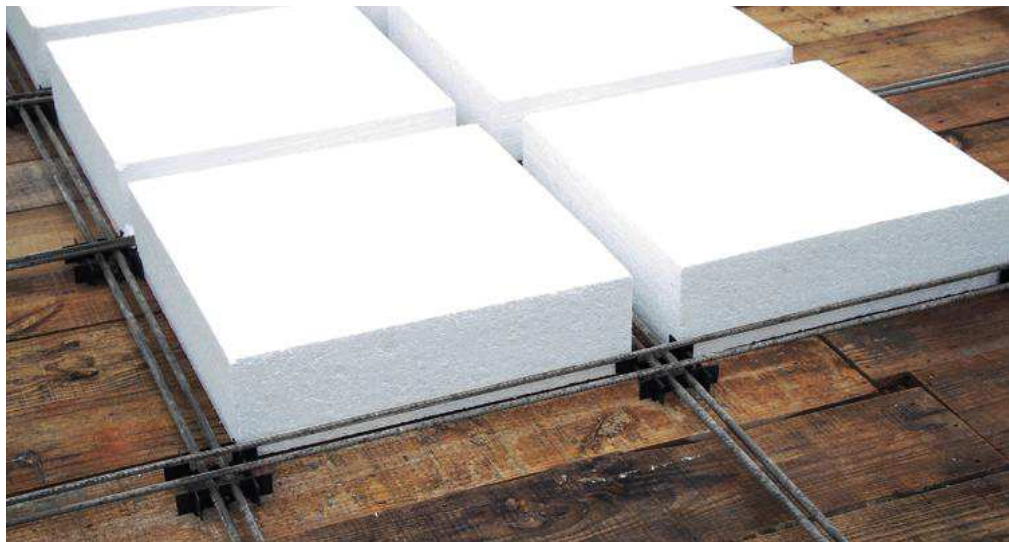
Figura 6 - Blocos de EPS sobre fôrma
