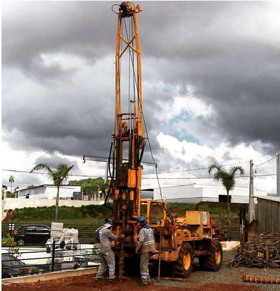
Figura 2. Equipamento mecanizado com martelo automático acoplado para a execução do ensaio SPT.
