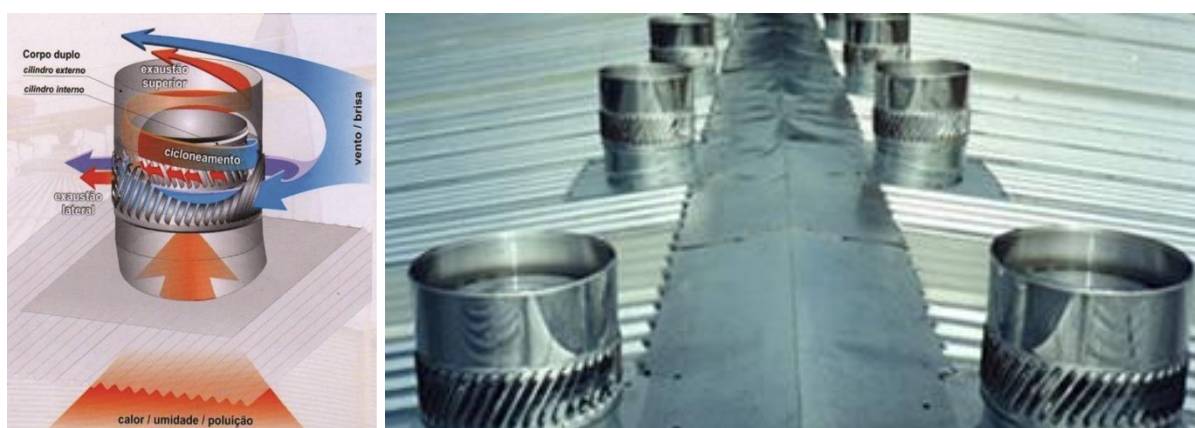
Figura 3 – Funcionamento do sistema Cycloar e o arranjo dos exaustores eólicos no teto da fábrica
