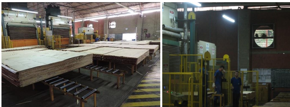
Figura 4 – Área de avaliação das condições térmicas (prensas a quente) no setor fabril Fonte: Autoria própria
