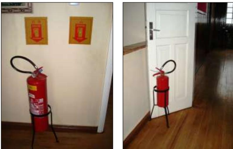
**Fotografia 5 - Extintores de incêndio em lugares equivocados no Município B**
