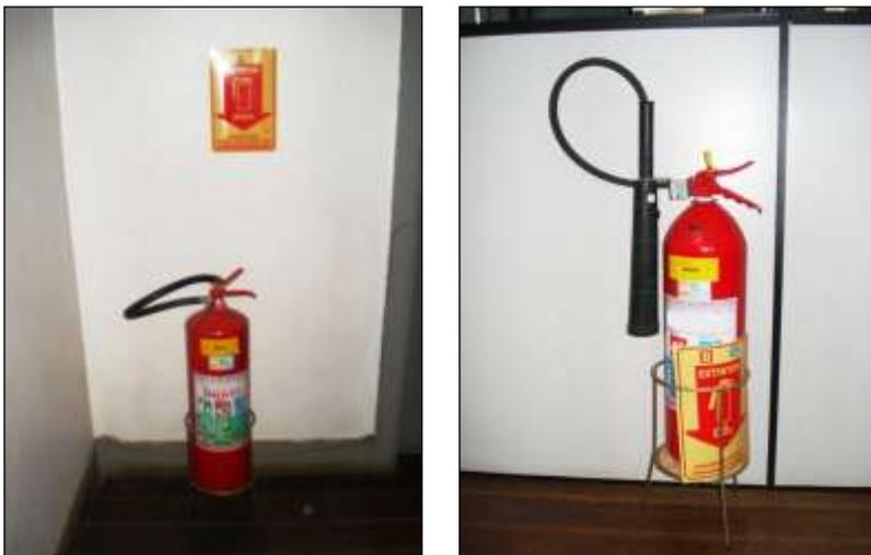
**Fotografia 10 - Sinalização de equipamentos de combate a incêndio no Município C em desconformidade com a NPT 020**
