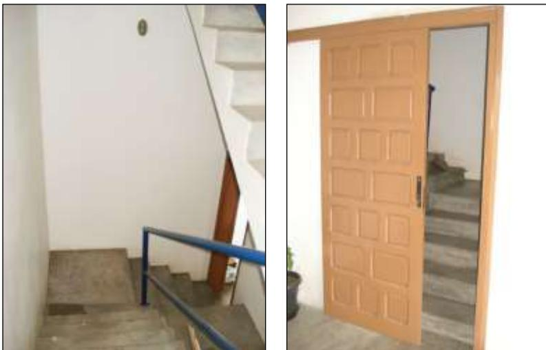
**Fotografia 14 - Escada e porta para saída de emergência, no Município A, com largura inferior ao disposto na NPT 011**
