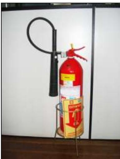
**Fotografia 6 - Extintor de incêndio com sinalização a adequar no Município C**
