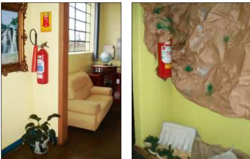
**Fotografia 4 - Extintores de incêndio obstruídos no Município A**
