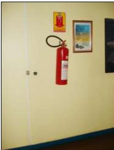
**Fotografia 8 - Padrão de sinalização de equipamentos de combate a incêndio no Município A**
