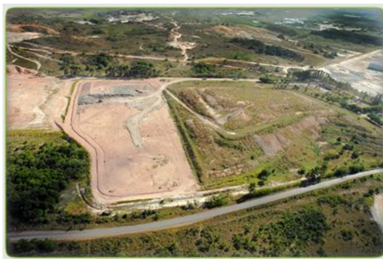
Figura 5- Foto aérea do Aterro Sanitário de Camaçari- Limpec Fonte: Limpec (2013)
