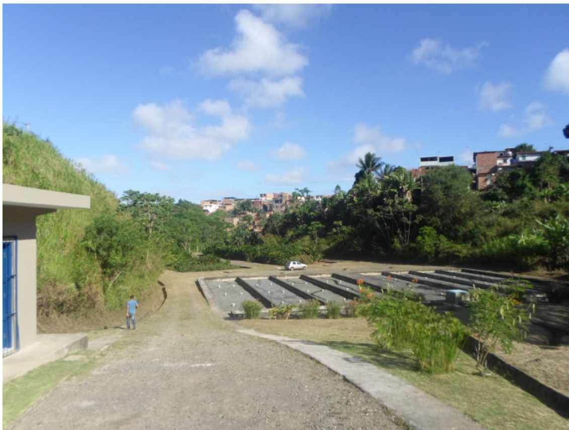
Figura 3 - ETE Tipo Wetland . Fazenda Grande II Fonte: Embasa, 2013.
