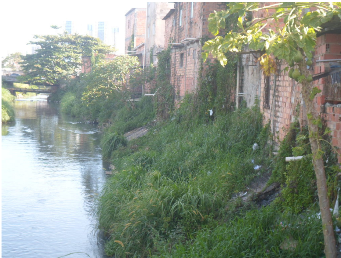
Figura 1 - Lançamento de esgoto residencial na calha principal do Rio Camarajipe Fonte: Aislã Teles, 2015.
