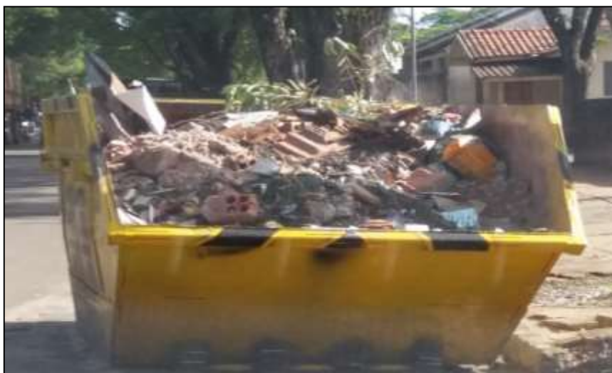
Figura 5: Caçamba coletora de RCD Fonte: Autoria própria (2018).
