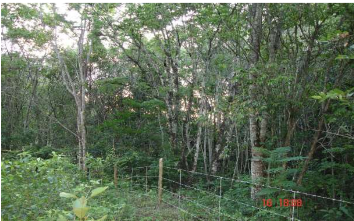
Figura 3 – Construção da Cerca Fonte: Autor, 2018.
