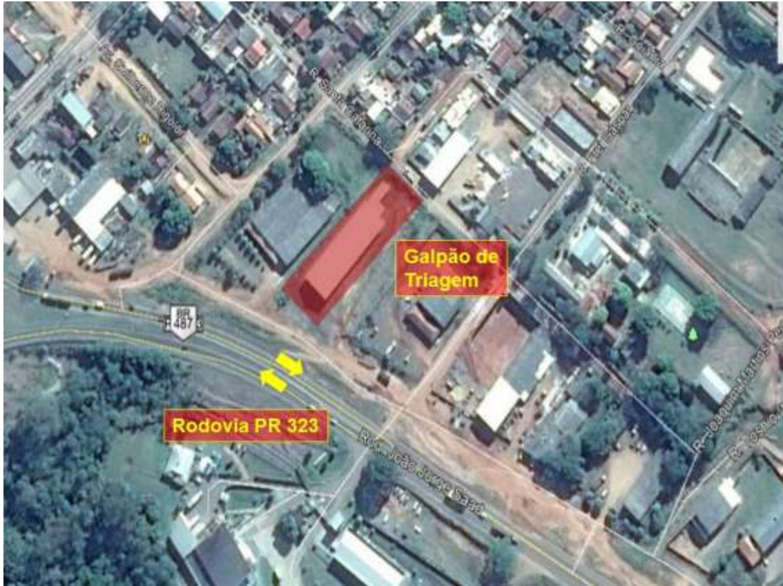
Figura 4 - Localização do Galpão de Triagem de Materiais Recicláveis Fonte: Google Earth (2017)
