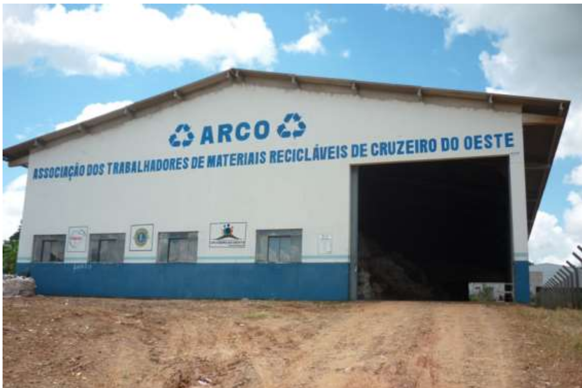
Figura 5 – Fachada do Galpão de Triagem de Materiais Recicláveis Fonte: Arquivo do autor (2017)
