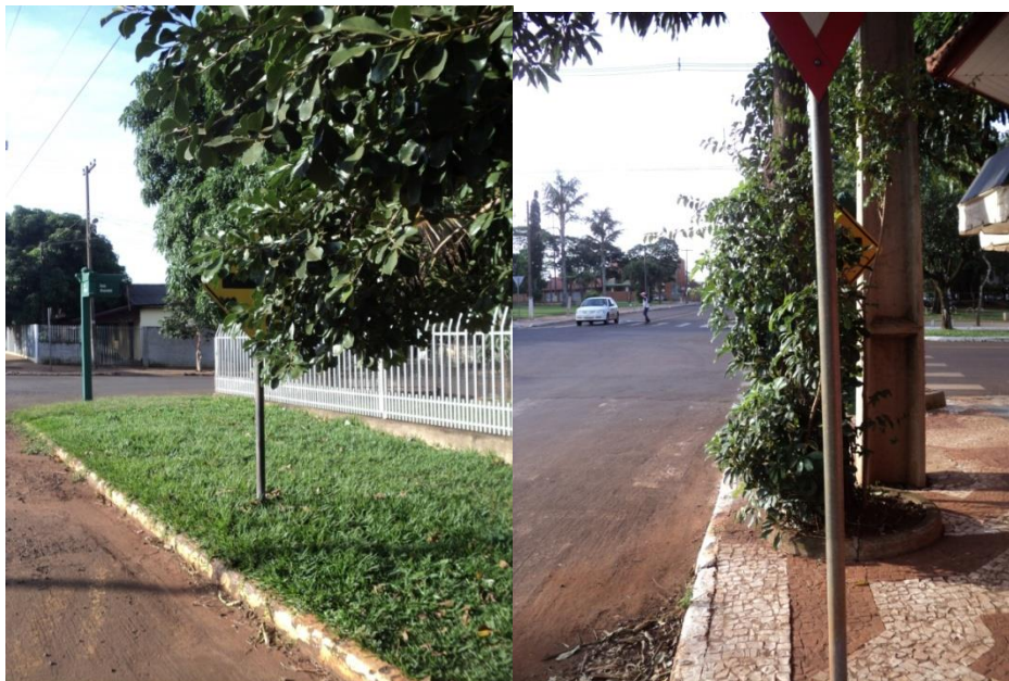
Figura 6 - Árvores em conflito com a sinalização
