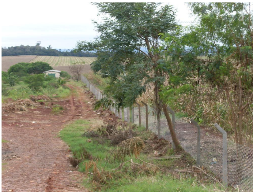
Figura 11 – Cerca de arame farpado situada na parte superior do Aterro.
