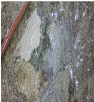
Figura 09–Resíduos de Cascão Retirados Conforme Necessidade
