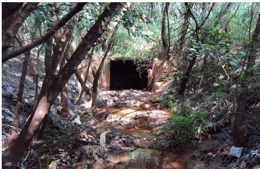
Figura 7 – Galeria de águas pluviais e resíduos sólidos preso a malha de arame do gabião.
