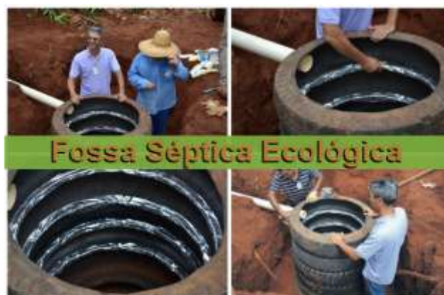
Figura 12 – Fossa séptica ecológica com uso de pneus
