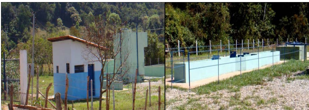
Figura 16 - ETE São Bartolomeu Fonte: SEMAE-OP (2013)
