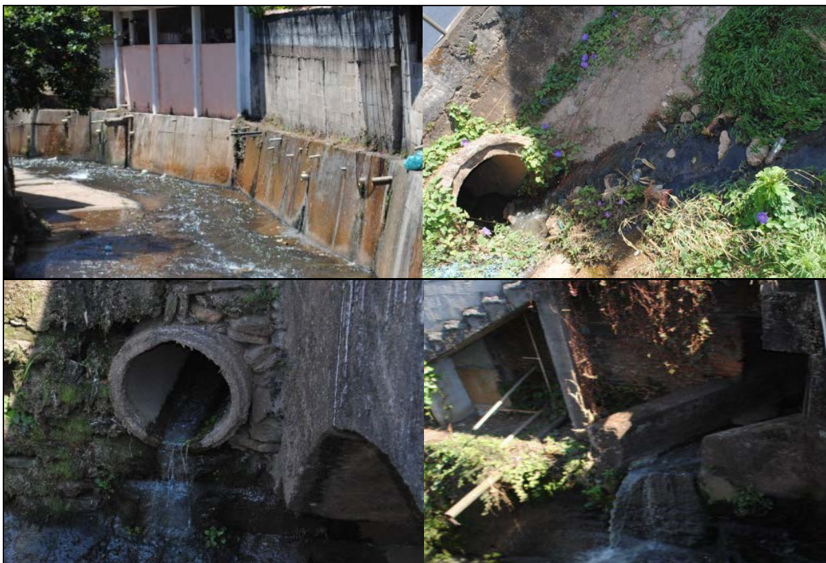
Figura 15 - Lançamentos de esgoto bruto em rios e galerias pluviais Fonte: Galiani (2014)
