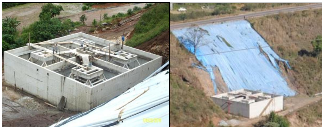
Figura 17 - Obra da ETE Osso de Boi na Sede de Ouro Preto Fonte: SEMAE-OP (2014)
