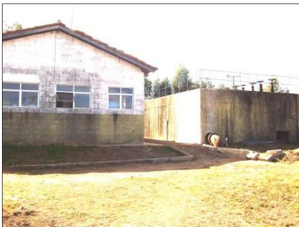
Figura 4 - Vista geral da ETA Funil Fonte: SEMAE-OP (2013)
