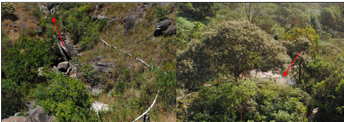
Figura 2 - Exemplos de captação - problemas de isolamento e distribuição (destaque para os locais de captação) Fonte: Galiani (2014)
