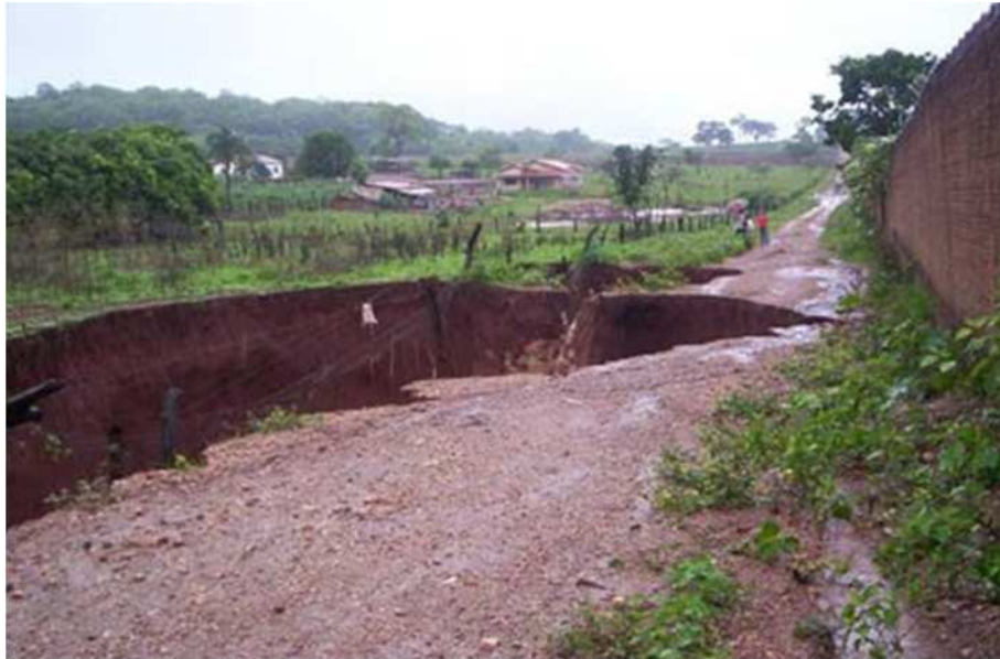
Figura 4 – Foto de subsidência ocorrida em dezembro de 2005 em Vazante MG Fonte: Ecodenúncia (2006).
