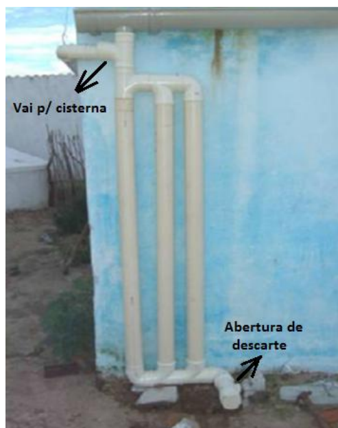
Figura 14: Dispositivo de descarte (desviUFPE) Fonte: Figueiras, 2013.
