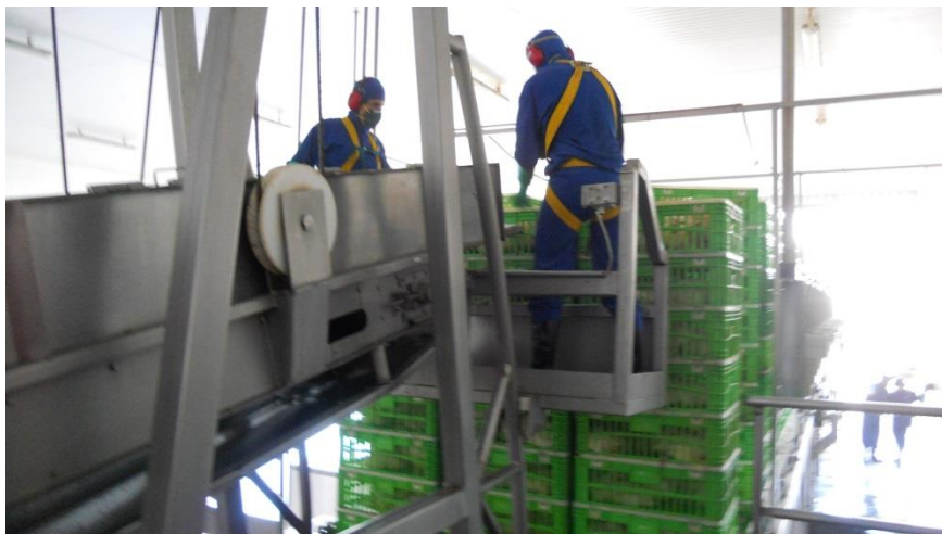
Figura 1 - Seção Recepção de Aves - Recebimento de Gaiolas
