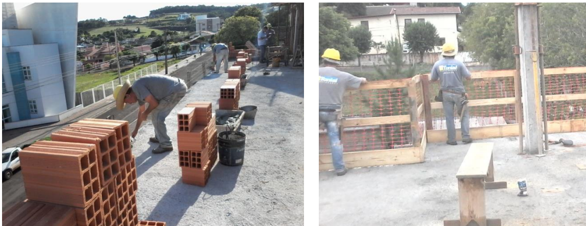
Figura 8 – Antes e depois da implantação de EPI's/EPC's. Fonte: Autoria Própria.
