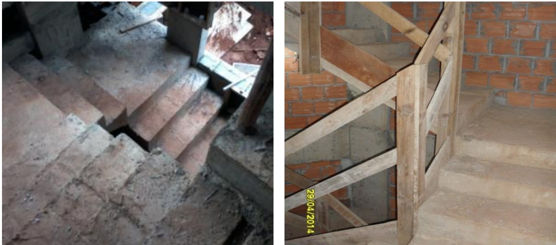
Figura 10 – Antes e depois da implantação de EPC's - Escadas. Fonte: Autoria Própria.
