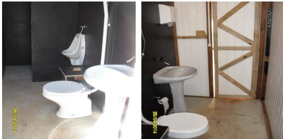
Figura 3 – Sanitário da obra. Fonte: Autoria Própria.
