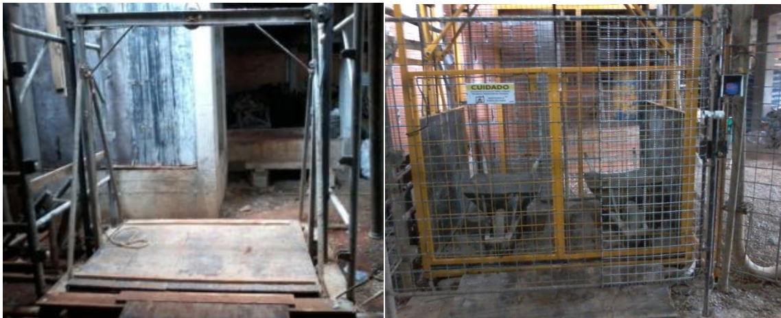
Figura 11 – Antes e depois da implantação de EPC's - Elevador. Fonte: Autoria Própria.
