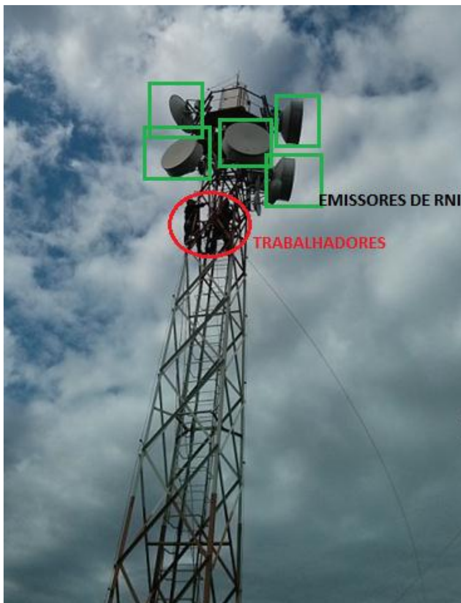
Figura 6 – Trabalhadores e Equipamentos em funcionamento
