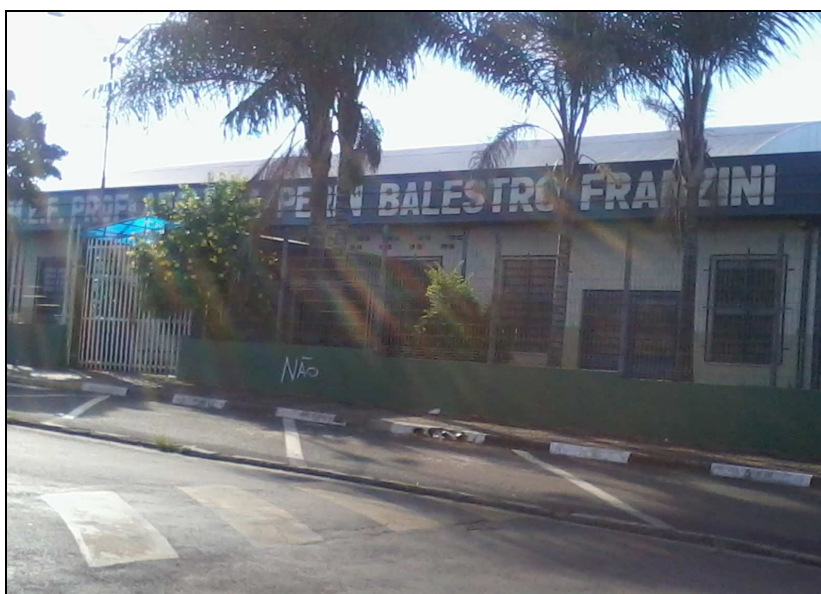
Figura 1: Fachada da Escola EMEF.ª Profª Adalgisa P. B. Franzini. Fonte: Autoria própria
