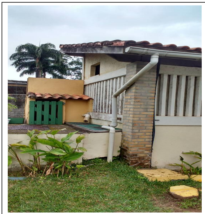
Figura 15 - Sistema de Coleta da Água da Chuva
