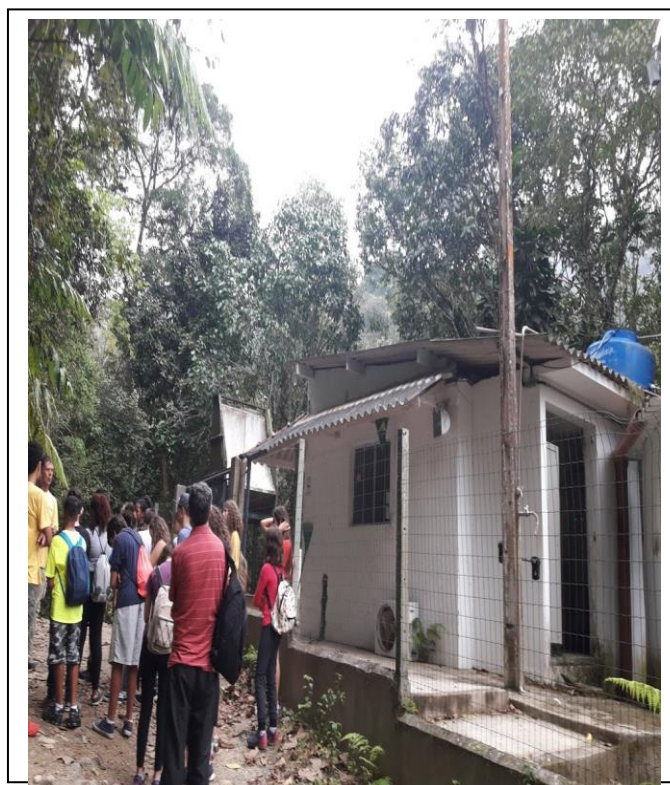
Figura 1 - Estação de Tratamento de água
