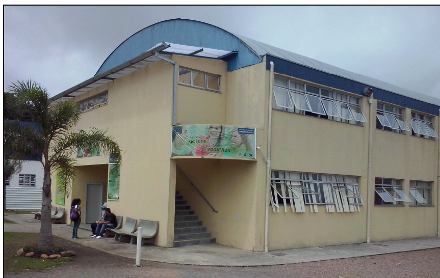
Figura 2 - Fachada do Colégio Sesi/Famec – São José dos Pinhais.
