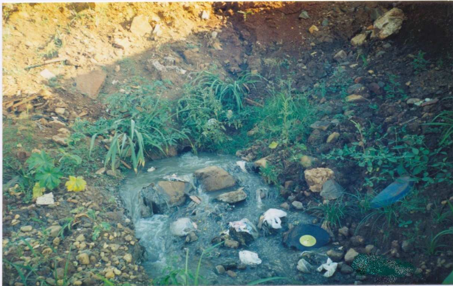
DETALHE DA SAÍDA DE ESGOTO ( ATÉ COM DISCO DE VINIL )
