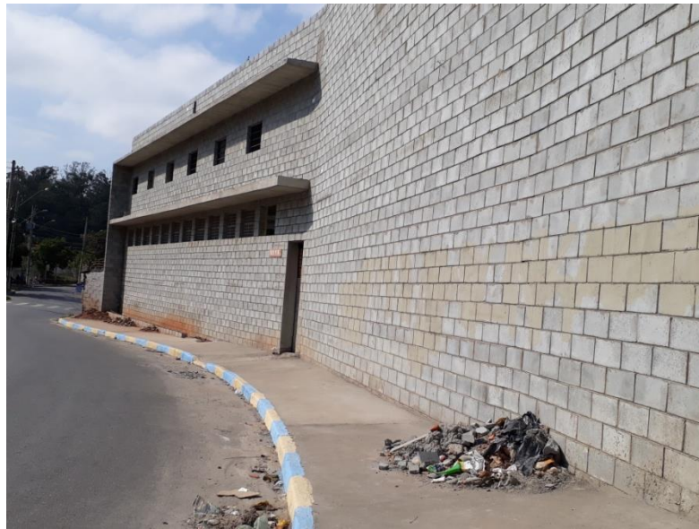
Figura 22 – Fachada da futura sede da CooperAreis
