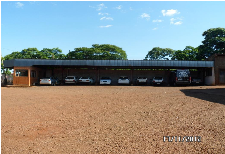
Figura 6- Foto da garagem 01
