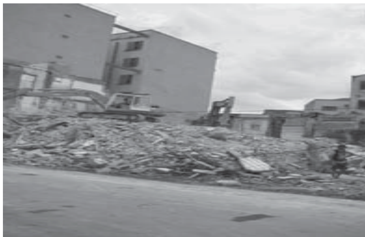
Figura 1 - Demolição na Luz (Hélène Rivière D'Arc, 3/11/2007 – Retirado de Frúgoli, 2009 – acesso em 15/10/11)
