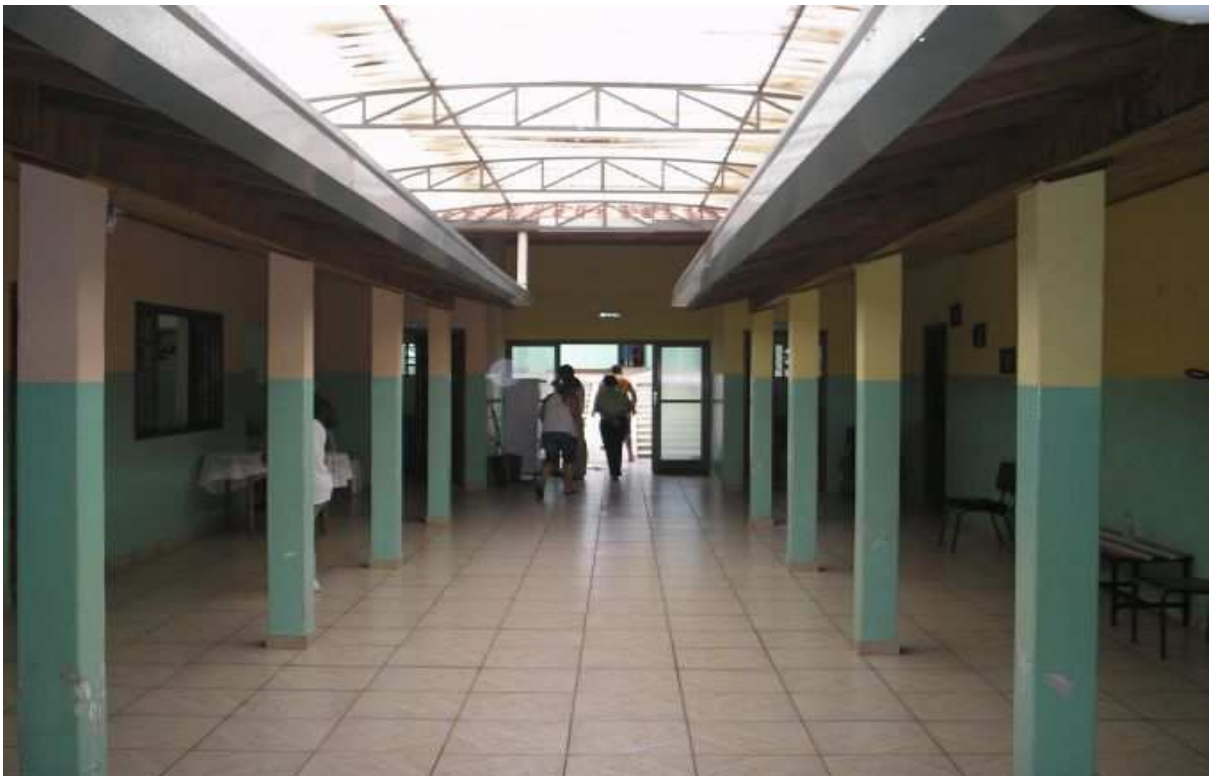
Fig. 2 – Vista interna da Escola La Salette.
