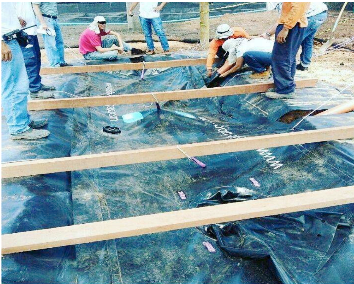
Figura 12 - Instalação da Planta Piloto de Biogás.
