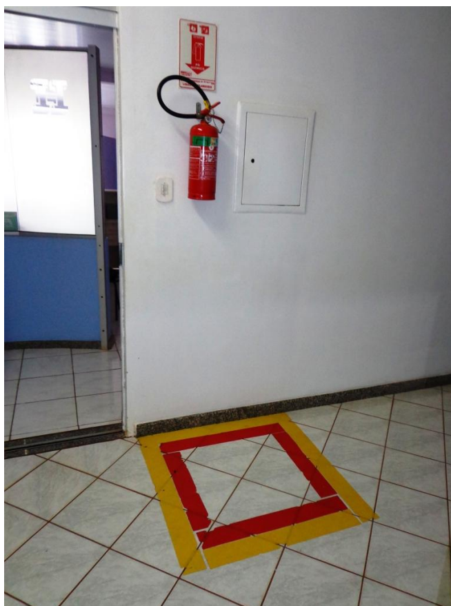
Fotografia 10 - Extintor de Pó Químico Seco, Hospital Santa Mônica Fonte: Rocha, Cláudia. 2012.
