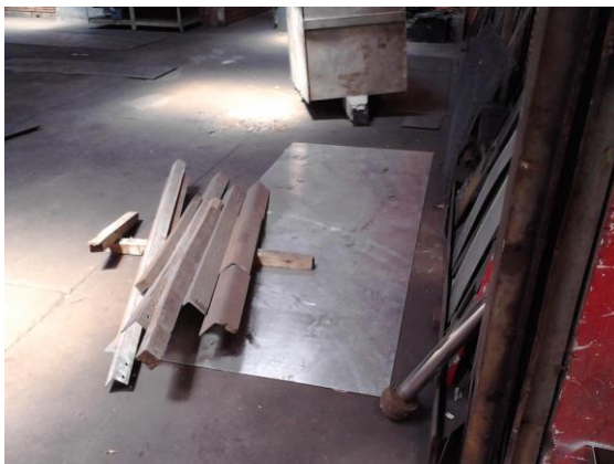
Fotografia 21 – Risco de Acidentes
