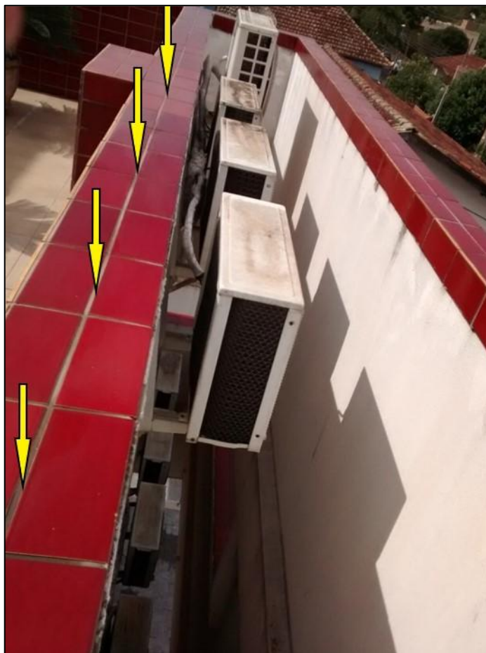
Figura 22. Segundo espaço de trabalho no solarium do pavimento 3.
