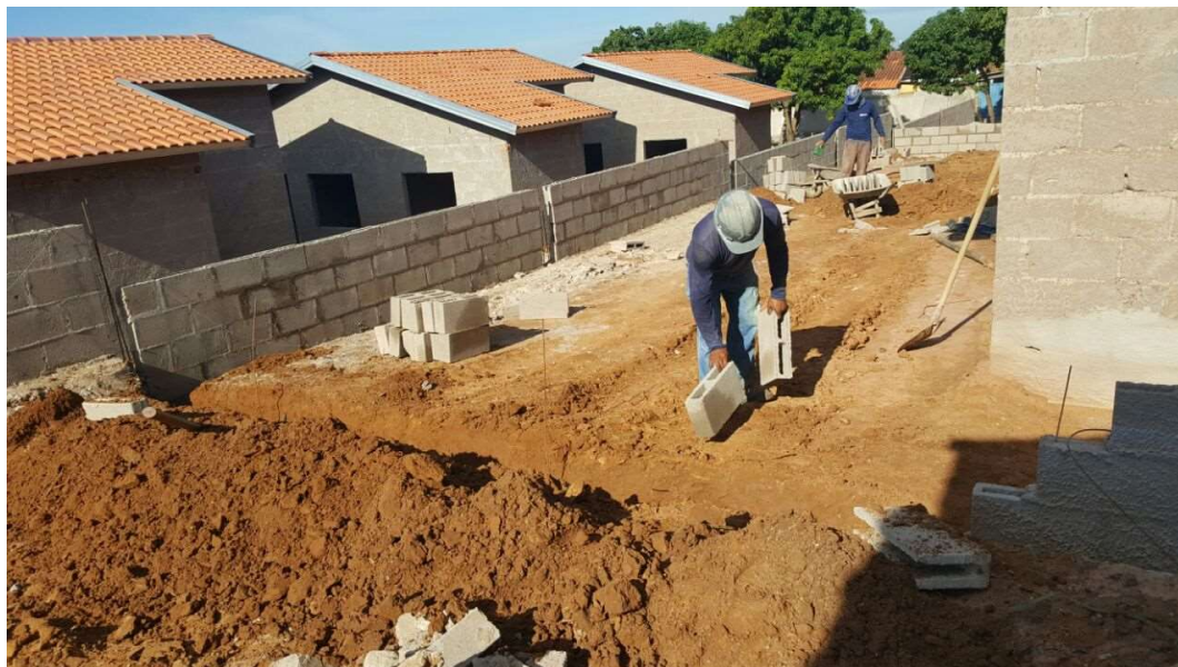
Fotografia 1 - Análise da etapa de transporte dos blocos de concretos. Fonte: Autoria própria.
