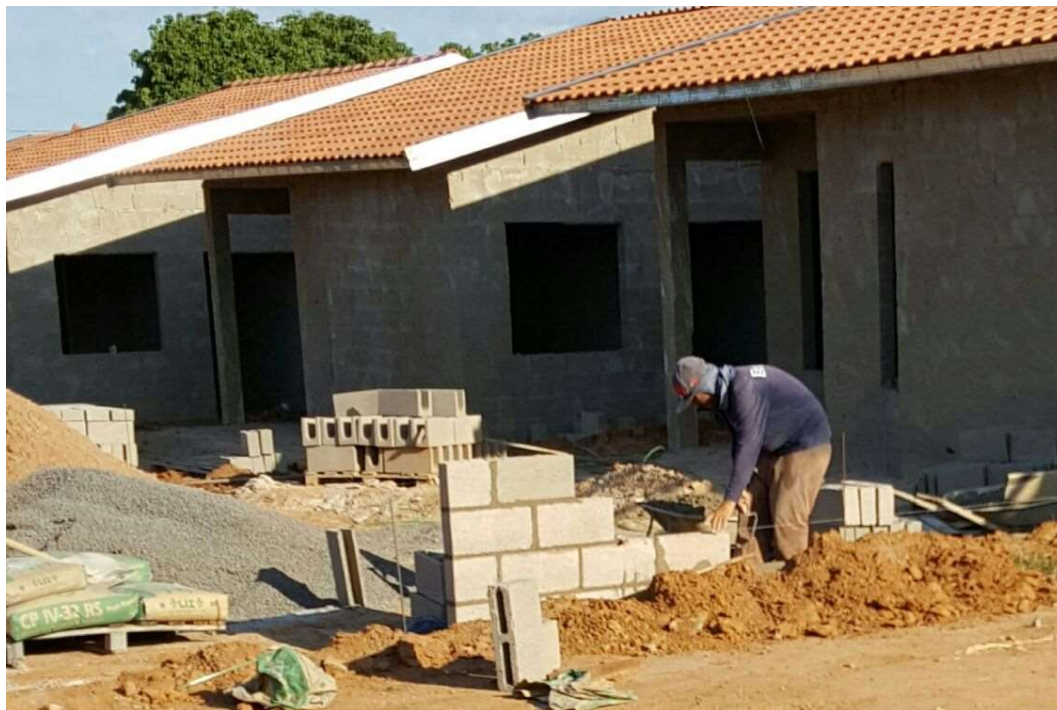
Fotografia 3 - Análise da etapa da construção do muro. Fonte: Autoria própria.
