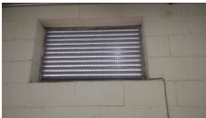
Fotografia 5 – Janela para circulação de ar com grades Fonte: Autoria própria
