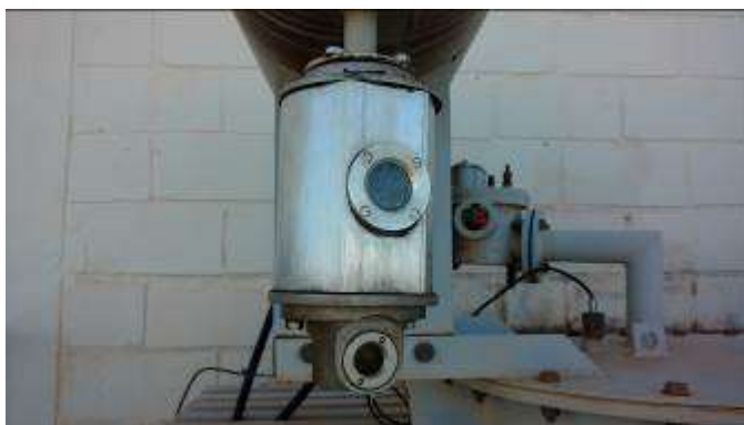
Fotografia 31 – Secador de Ar, relé de gás
