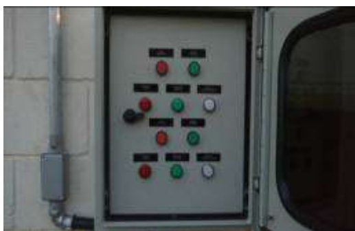
Fotografia 48 – Painel de Comando Remoto Fonte: Autoria própria
