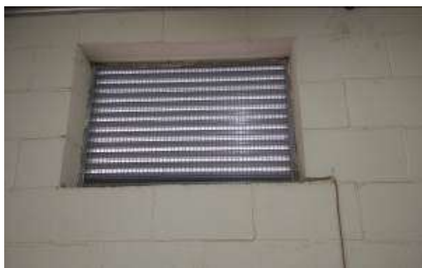
Fotografia 61 – Aterramento das partes metálicas. Fonte: Autoria própria
