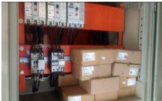
Fotografia 53 – Materiais armazenados dentro de painéis Fonte: Autoria própria
