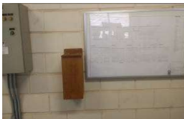
Fotografia 57 – Caixa para acondicionamento das luvas isolantes Fonte: Autoria própria
