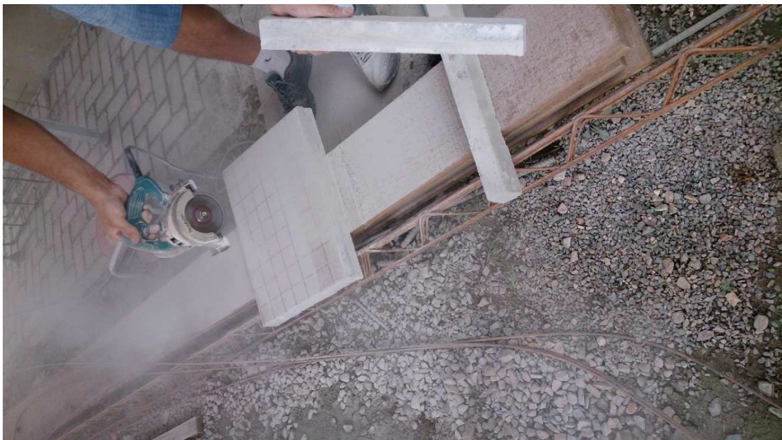
Figura 05. Corte dos blocos com serra de disco.
