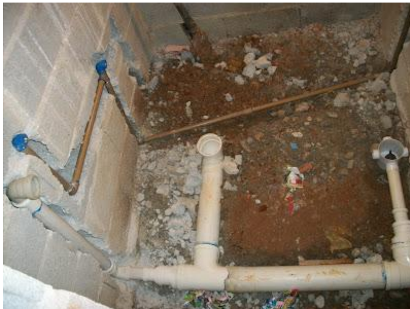
Figura 6 – Bolsas executadas com aquecimento de tubo
