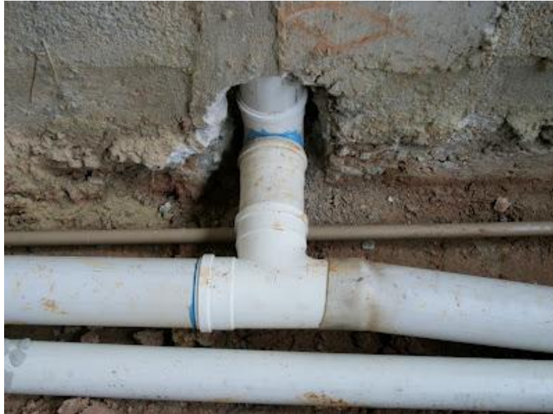
Figura 5 – Bolsas executadas com aquecimento de tubo
