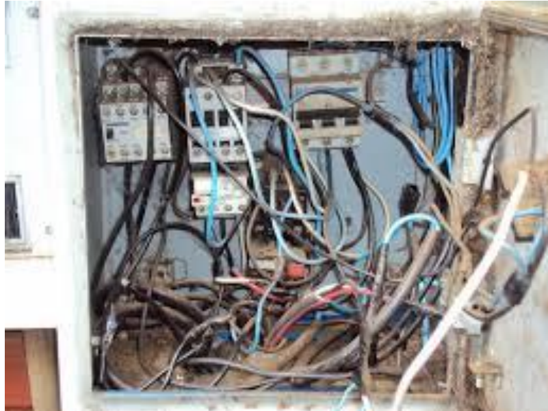
Figura 18 – Montagem de quadros
