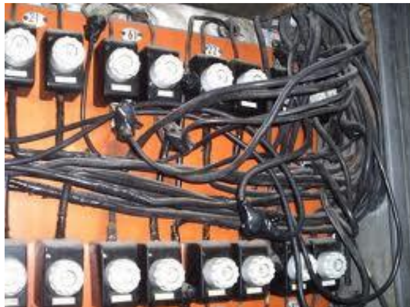
Figura 19 – Montagem de quadros
