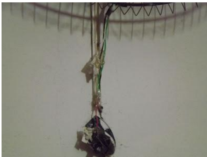
Figura 17 – Execução de emendas nas fiações
