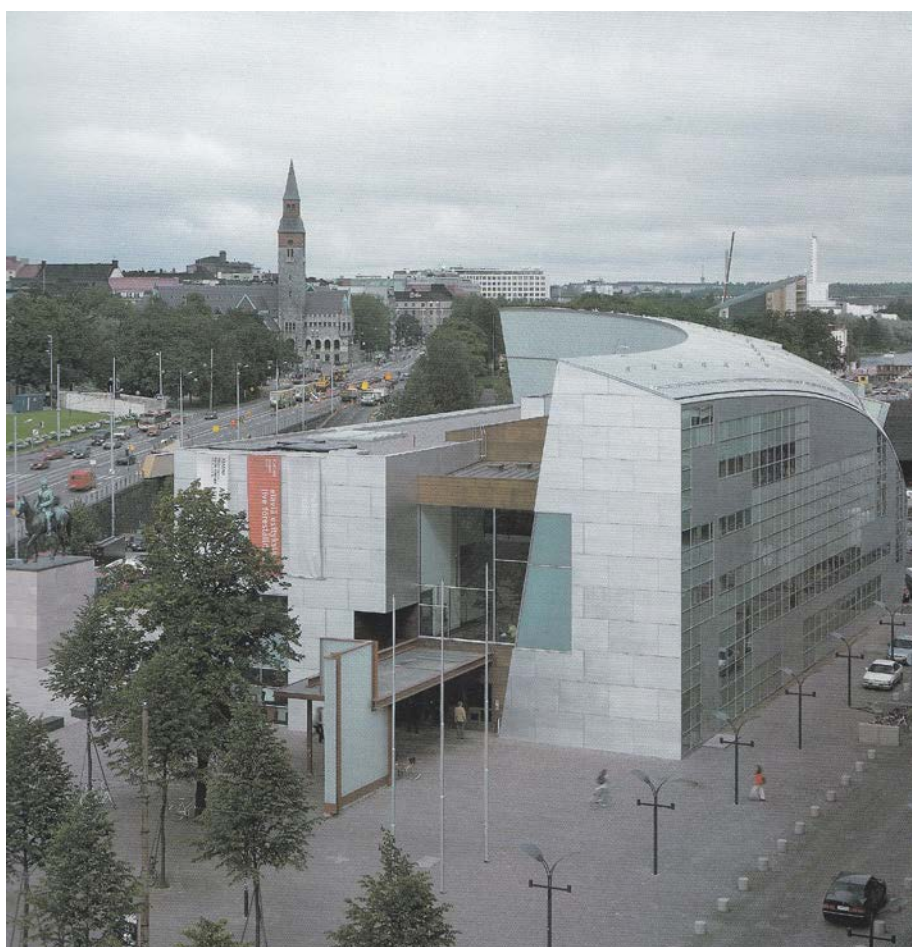
Fotografia 1 – Edifício do Museu de Arte Contemporânea de Helsinque
