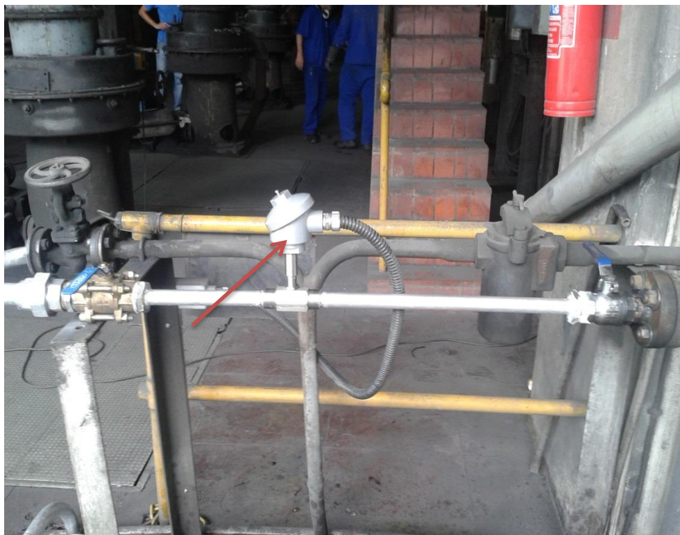
Figura 8 – Sistema de medição do Diesel (depois), com comunicação de dados.
