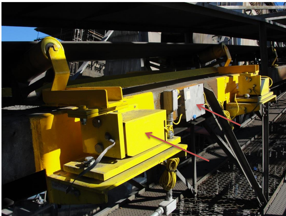
Figura 5 – Balança (depois) com células de carga e módulo de dados.
