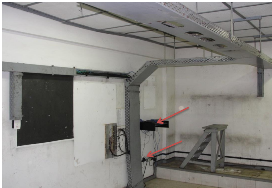
Figura 15 – Sala de Painéis (antes)
