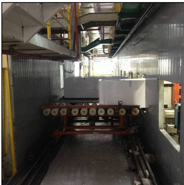
Figura 01: Carro de carga e descarga em operação.
