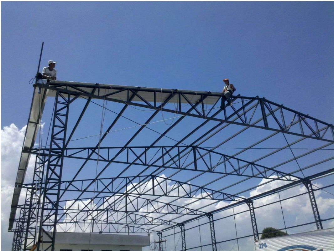
Figura 07: Detalhe das tesouras, acessórios e colocação das telhas
