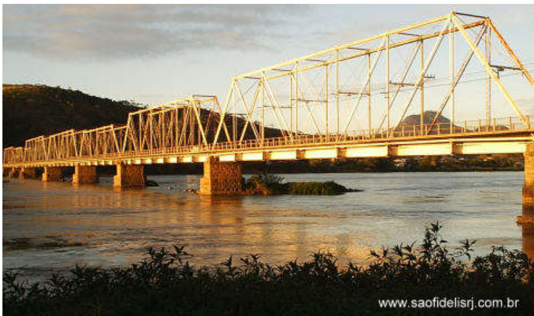
Figura 01: Ponte de Paraíba do Sul – Estaleiro Mauá – Niterói - RJ Fonte: www.saofidelisrj.com.br (2016)
