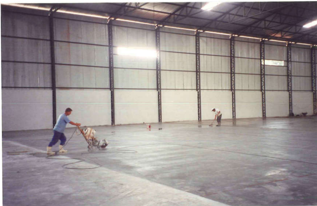
Figura 03: Elevação lateral da obra Fonte: Acervo do autor (2016)
