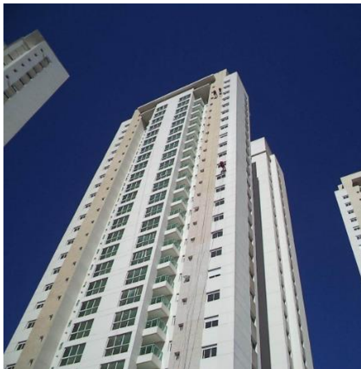
Figura 17: Trabalho sendo executado por cordas. (Fonte: empresa estudada).
