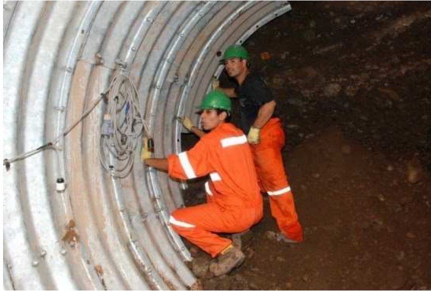
Figura 20 - Montagem dos anéis Fonte: Naresi (2016)
