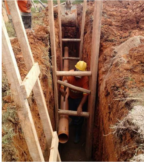
Figura 9 - Escoramento do tipo Pontaletes de Madeira Fonte: Construferris (2016)
