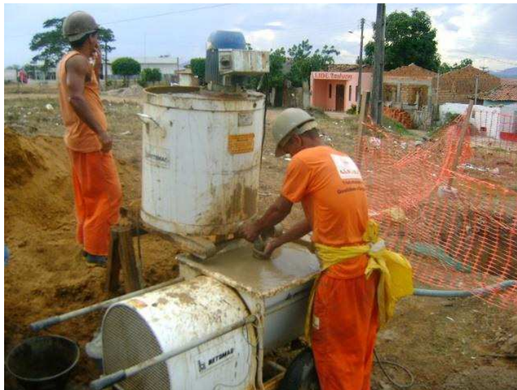
Figura 21 - Preparo de solo cimento para injeção Fonte: Fortes (2010)
