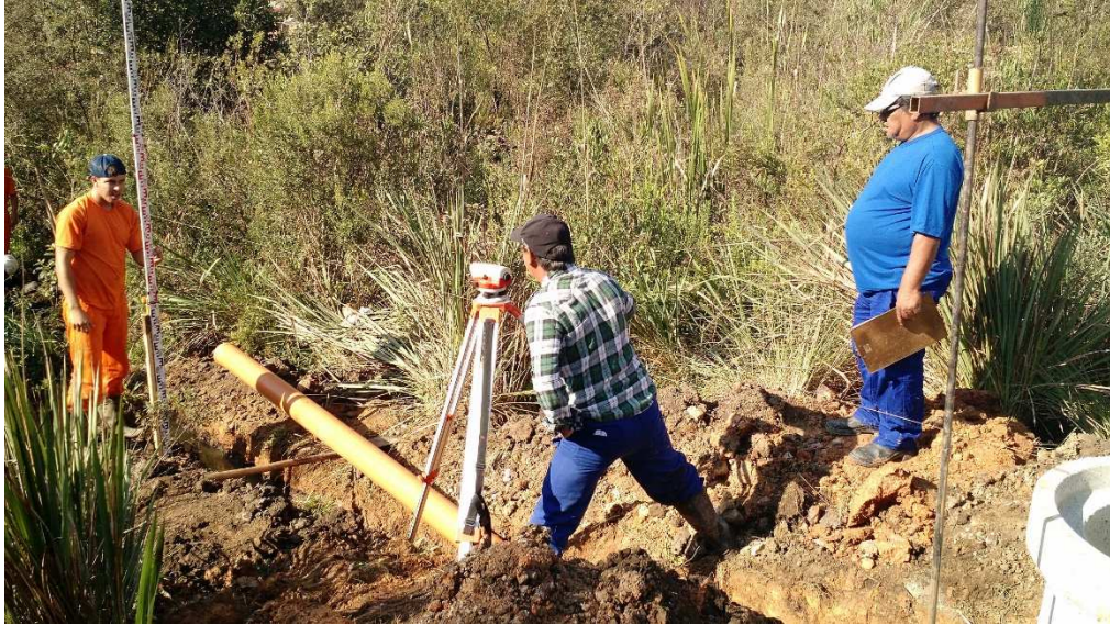
Figura 5 - Equipe de topografia nivelando trecho de execução de rede coletora de esgoto Fonte: Construferr (2016)
