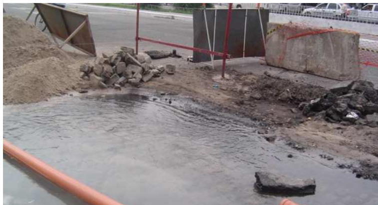
Figura 10 - Esgotamento de água da chuva retida na vala Fonte: Rodrigues (2008)
