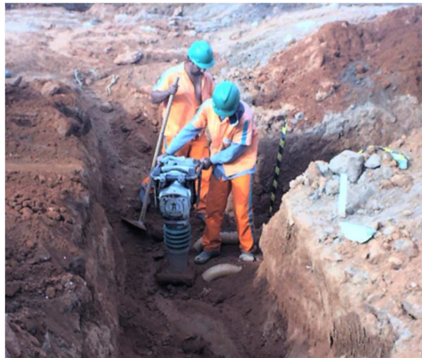
Figura 13 - Compactação de vala com “sapo mecânico” Fonte: Construferris (2016)
