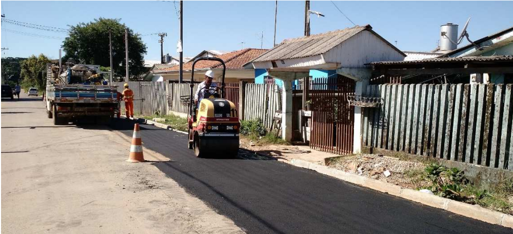
Figura 14 - Rolo liso compactando pavimento asfáltico Fonte: Construferrri (2016)
