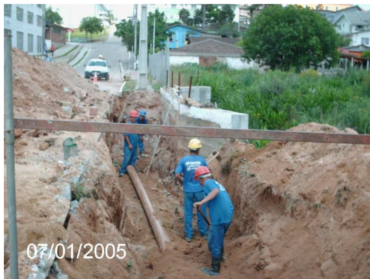
Figura 12 - Assentamento sendo executado de forma manual Fonte: Construferrri (2016)
