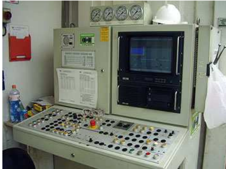
Figura 36 - Sistema computadorizado de controle de escavação Fonte: Matsui e Kochen (2003)
