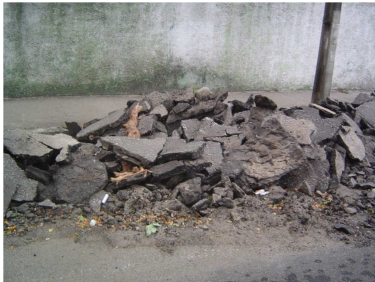
Figura 6 - Retirada de pavimentação asfáltica Fonte: RODRIGUES (2008)
