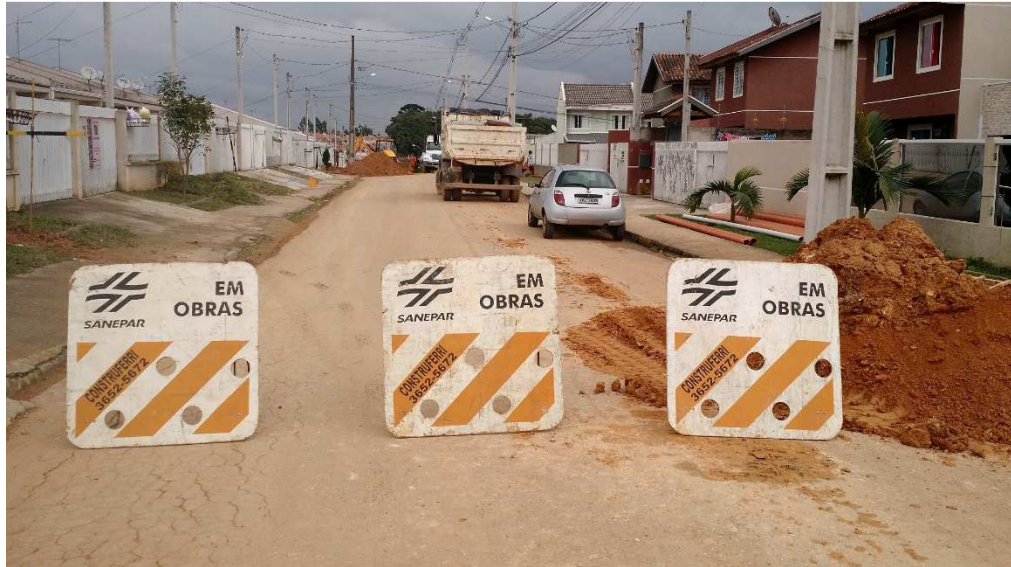
Figura 4 - Sinalização com placas de madeira Fonte: Construferrí (2016)
