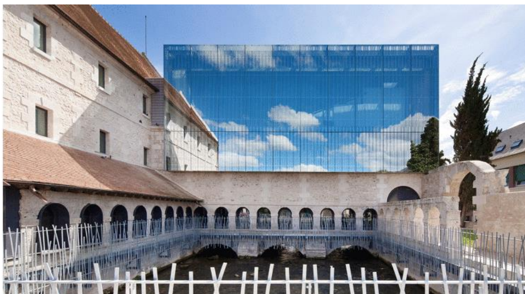
FIGURA 16 – ECOLE DE MUSIQUE EM LOUVIERS, FRANÇA. Fonte: Opus5 Architectes (2012).
