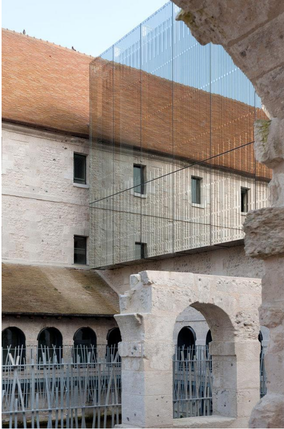
FIGURA 15 – ECOLE DE MUSIQUE EM LOUVIERS, FRANÇA. Fonte: Opus5 Architectes (2012).
