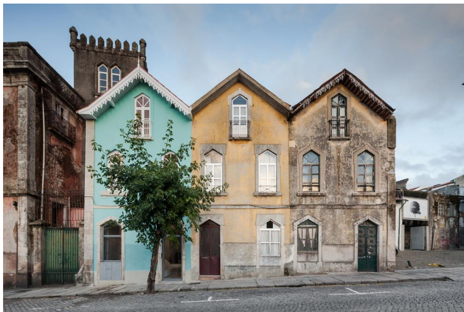
FIGURA 19 – CHALÉ DAS TRÊS ESQUINAS. SÉ, BRAGA, PORTUGAL.
