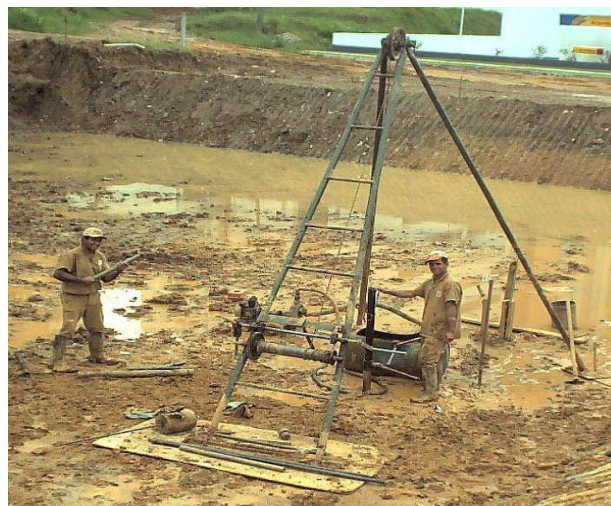
Figura 8: Execução do serviço de sondagem Fonte: O autor.
