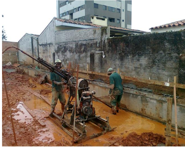
Figura 9: Serviço de atirantamento em cortina de estacas Fonte: O autor.
