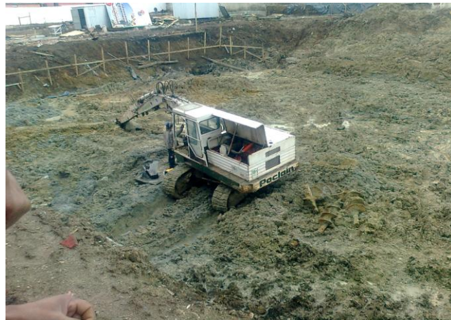
Figura 10: Serviço de execução de estacas escavadas de fundação Fonte: O autor.
