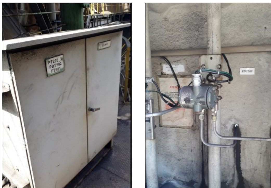
Figura 4.6 – Transmissor de pressão diferencial PT502
